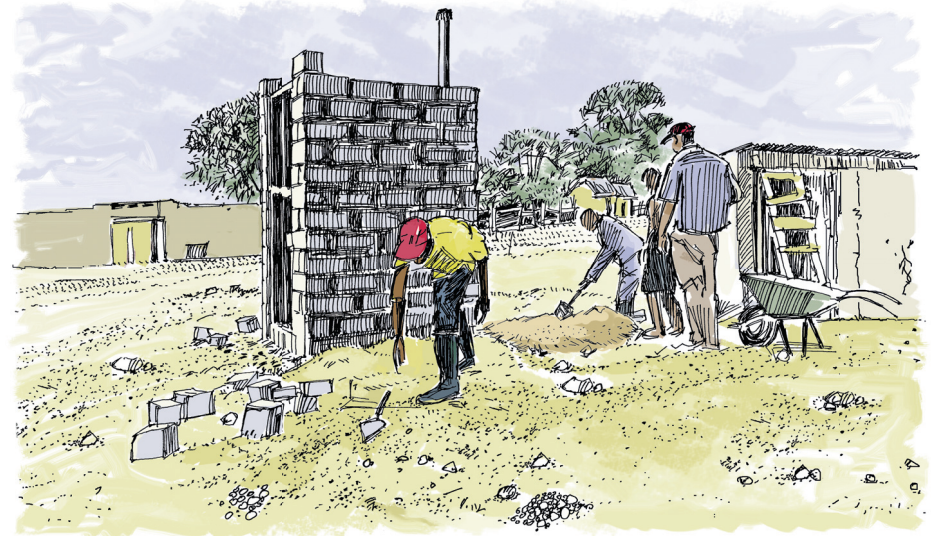
Figure 6. Une latrine VIP en construction
